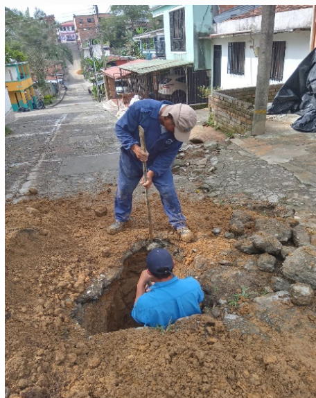
Reparación de daños en Guabitas
