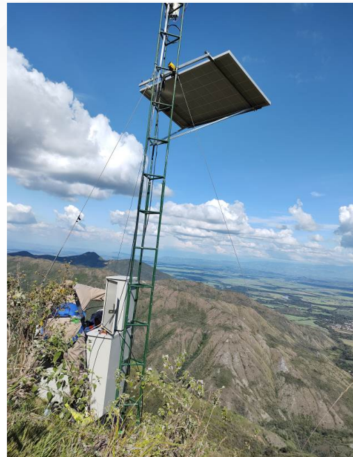
Nuevo montaje de gabinete y equipos en Cerro Cabuyal. Enlace.
