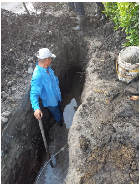
Reparación de daños en Alcalá
