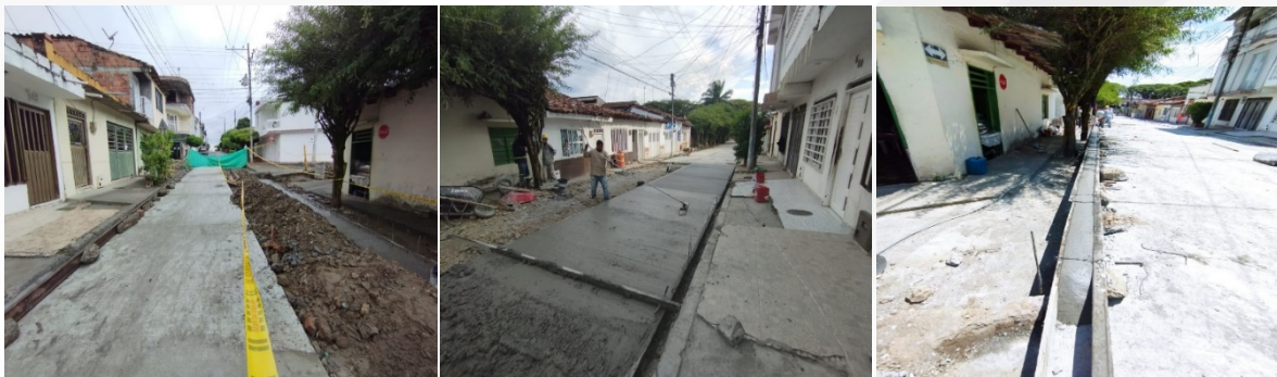
Reposición Redes de Alcantarillado y Pavimento Municipio de Zarzal
