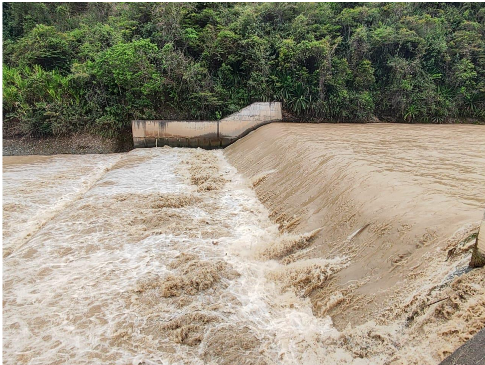
Foto 1. Bocatoma Voladeros Marzo 2023.
