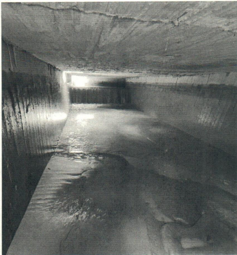
Foto 4. Desarenadores Bocatoma voladeros – Marzo 2023
