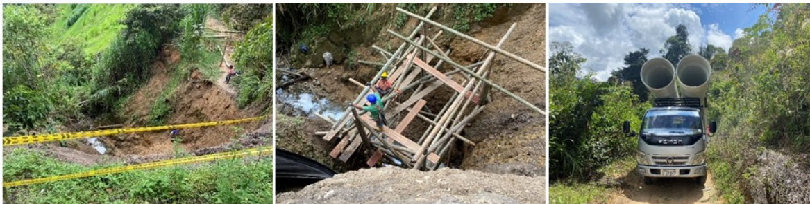
Construcción obras de mitigación por daño tubería Aguas Residuales Municipio de El Cairo
