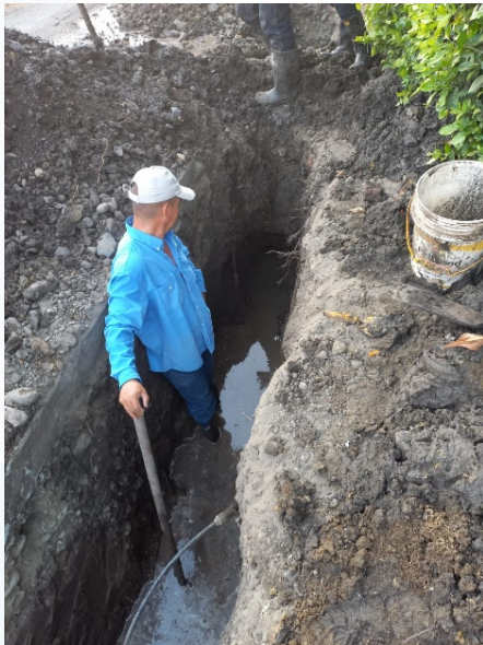
Reparación de daños en Alcalá
