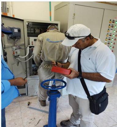
Instalación de equipos de comunicación
