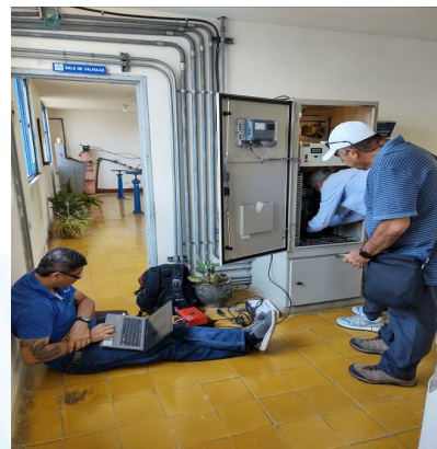
Instalación nuevos radios. PTAP Toro y Roldanillo
