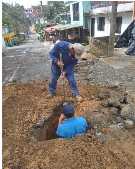
Reparación de daños en Guabitas
