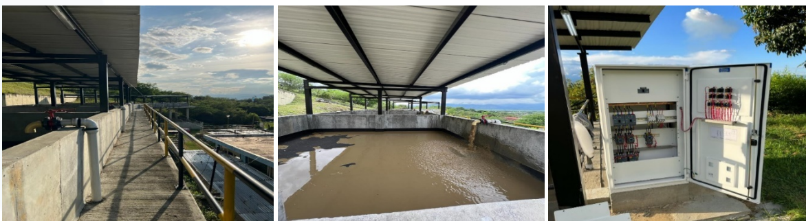
Construcción Sistema Tratamiento de Lodos y Optimización PTAP Municipio de San Pedro
