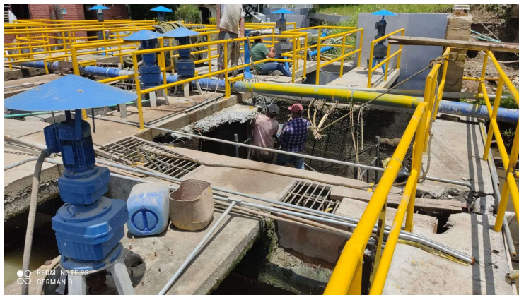
Fuente. Acuavalle Obras de optimización PTAP Andalucía 07/03/2022
