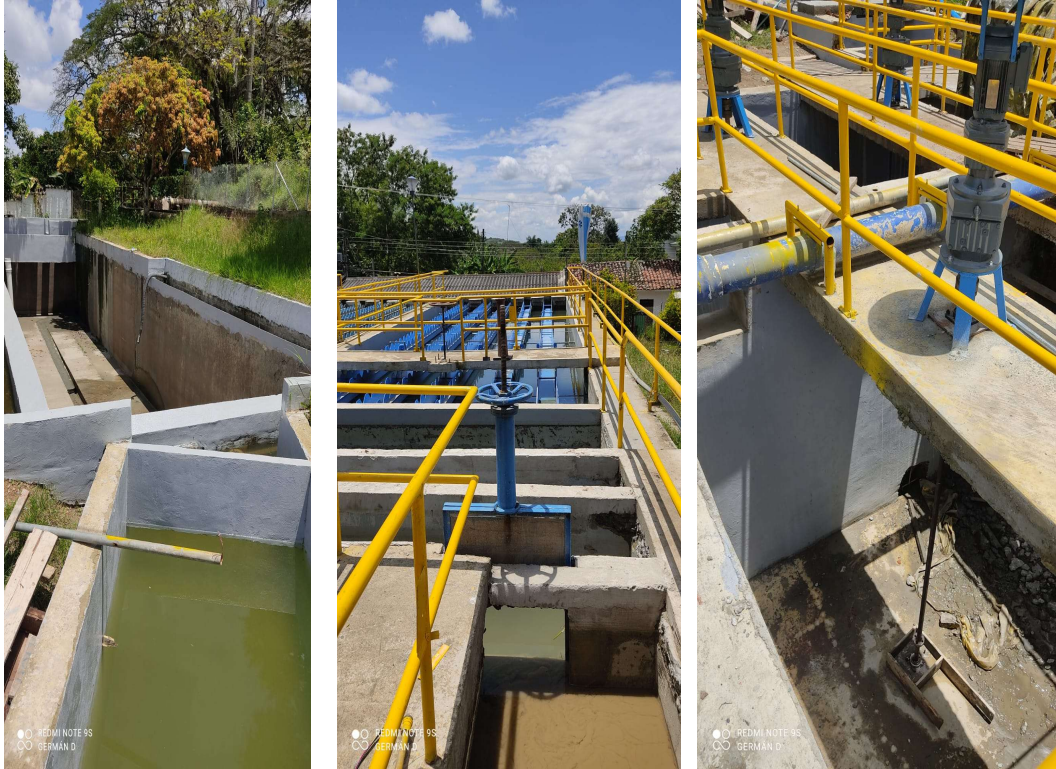
Fuente. Acuavalle Obras de optimización PTAP Andalucía 07/03/2022
