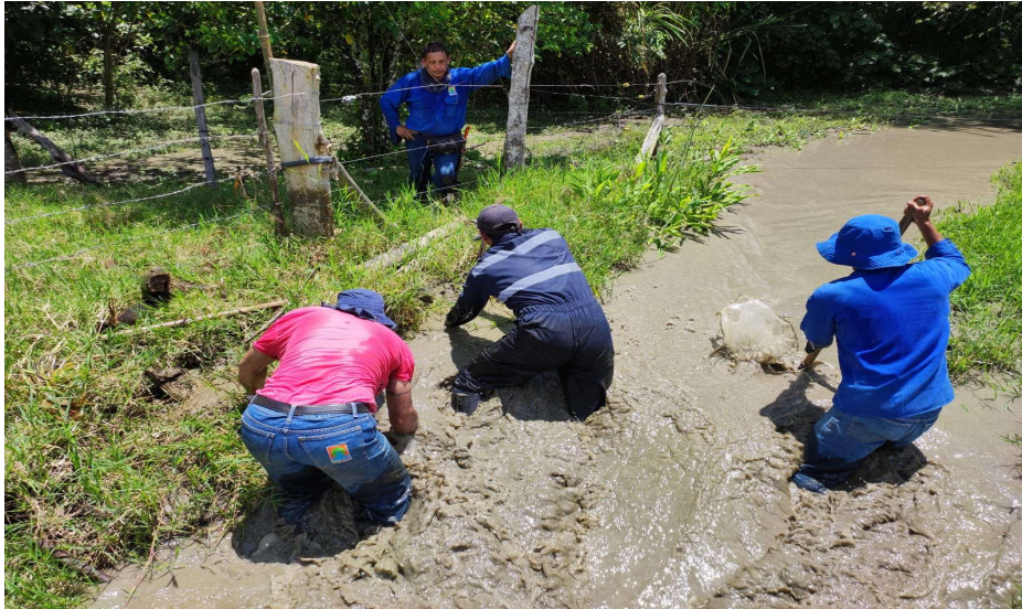
Foto 8. Mantenimiento canal municipal 07/03/2022
