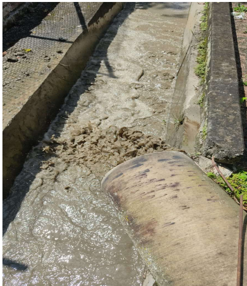
Foto 5. Llegada agua cruda PTAP ANDALUCIA. 07/03/2022. 10:45 AM
