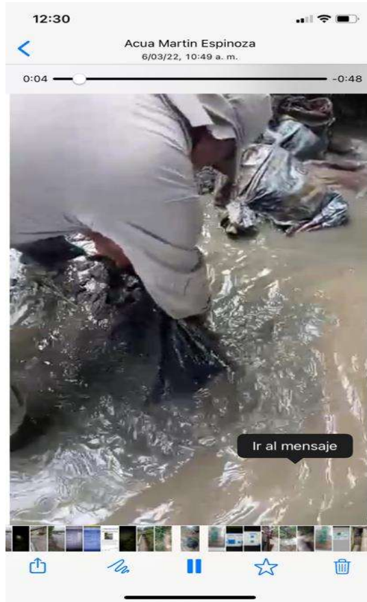
Foto 7. Mantenimiento y retiro de trinchos sobre el canal municipal 06/03/2022
