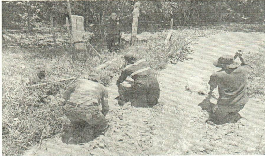
Foto 8. Mantenimiento canal municipal 07/03/2022
