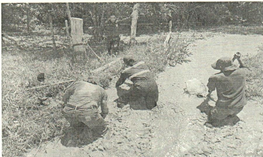
Foto 8. Mantenimiento canal municipal 07/03/2022
