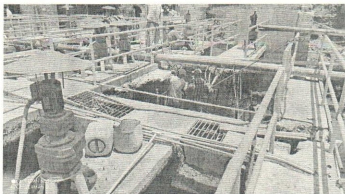
Fuente. Acuavalle Obras de optimización PTAP Andalucía 07/03/2022
