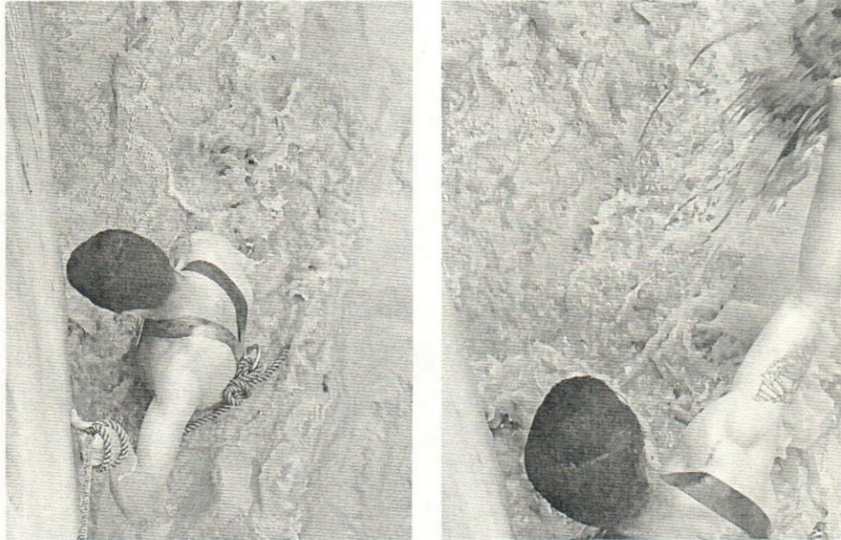
Foto 3 y 4. Limpieza externa rejilla de captación bocatoma voladeros. 06/03/2022
